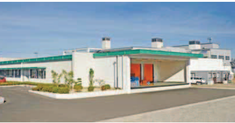
2014年に稼働を始め、クリーンな作業環境を実現した鷹取工場
